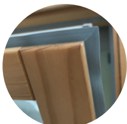
Guarnizione perimetrale del battente saldata agli angoli
