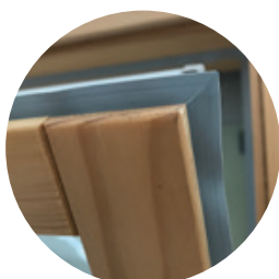
Guarnizioni perimetrali del battente saldate agli angoli
