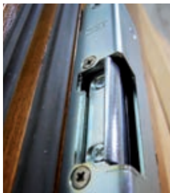
riscontro elettrico per aperture serrature con comando a distanza
