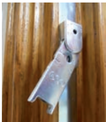
Riscontro di sicurezza per ante a ribalta. Impedisce l'apertura accidentale degli infissi quando aperti in por il ricambio dell'aria
