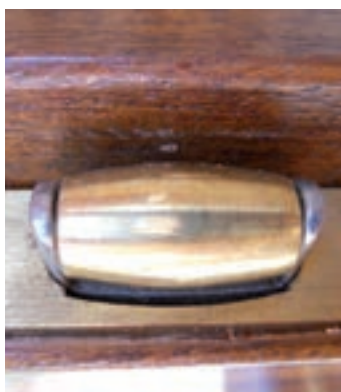
Scrocco serratura a molla che consente l'apertura a spinta delle serrature sia dell'interno che dall'esterno
